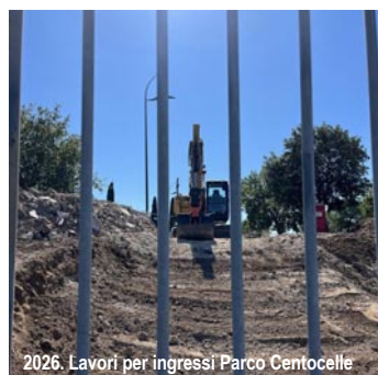
2026. Lavori per ingressi Parco Centocelle
